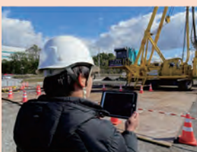
遠隔で状況確認中
